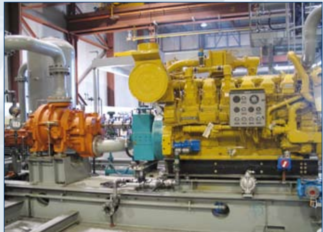
Pumpenantrieb / pump drive
